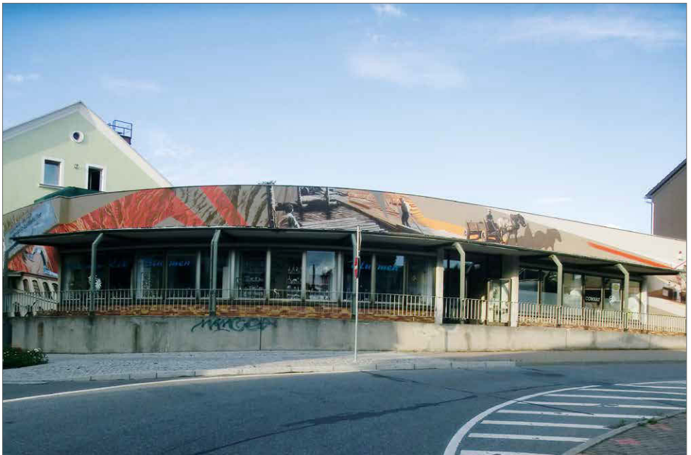
Abbildung 8 – Gesamtansicht des Gebäudes mit der Abfolge der Fassadenmalerei
