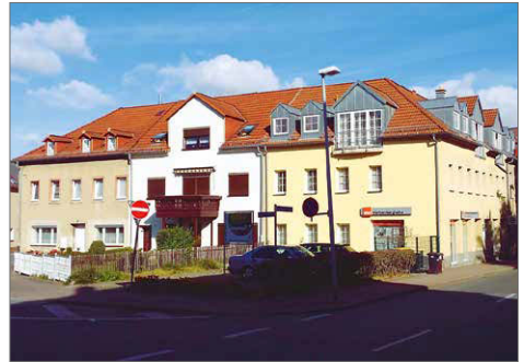
Abbildung 18: Heutige bauliche Situation am Standort des ehemaligen Technikums am Sonnenplatz.
