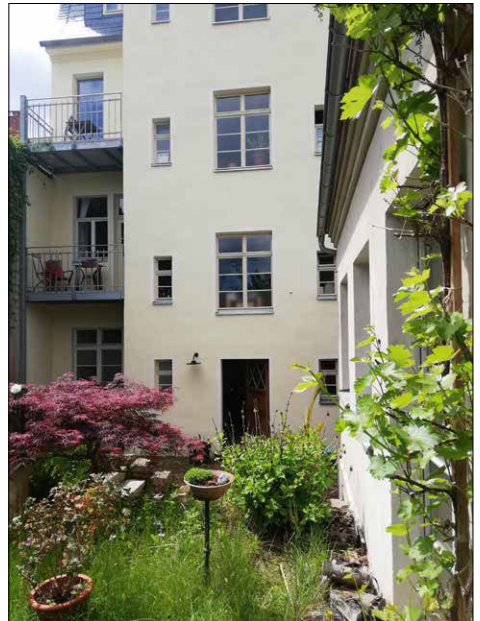
Abbildung 15: Von besonderer gestalterischer Qualität erweist sich auch die Rückansicht des Gebäudes Altenhainer Straße 13
